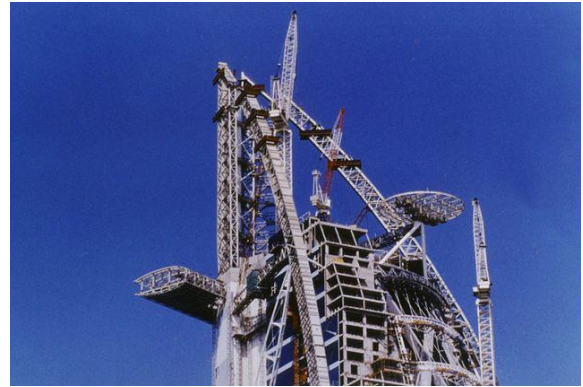
شكل (17)المراحل النهائية للانشاء وتشكيل قمة المبنى حيث مهبط الطائرات والملعب
