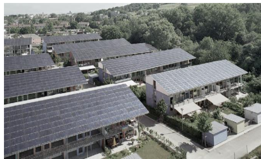
شكل (8): استخدام الخلايا الكهروضوئية في المباني صفرية الطاقة
